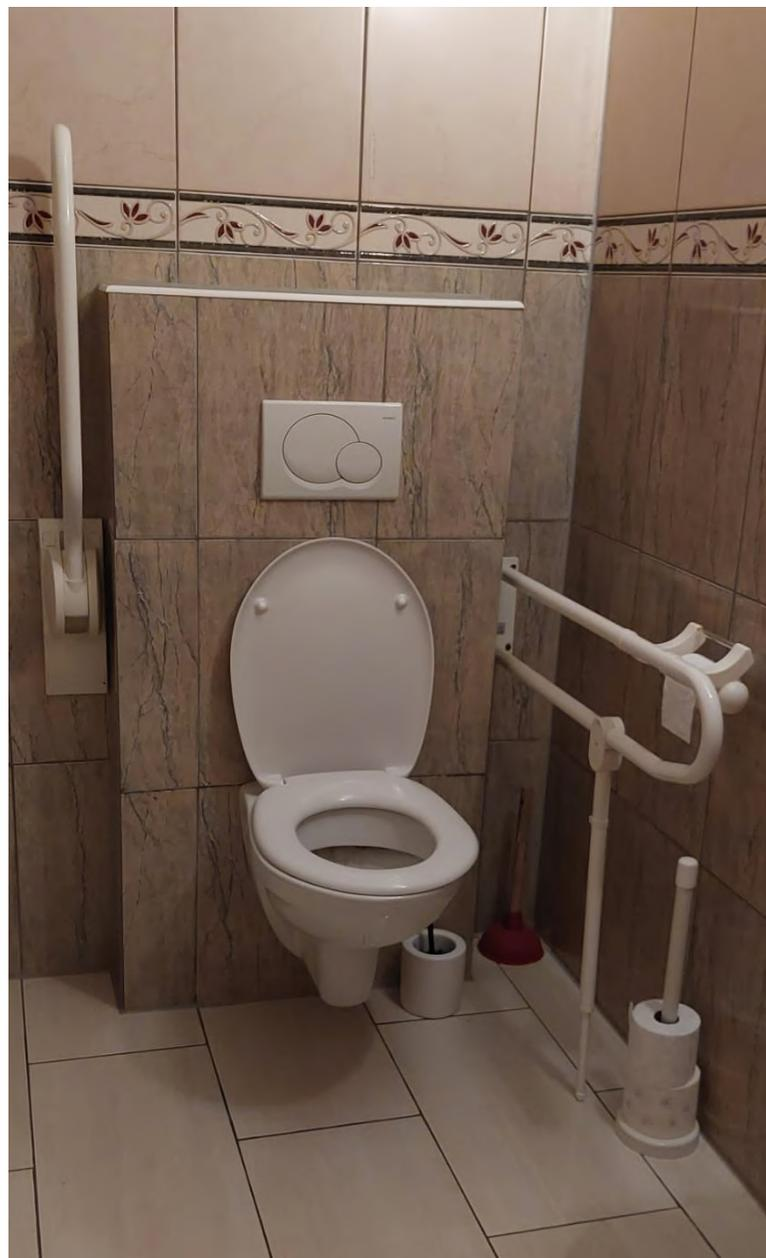
Barres d'appui dans un WC adapté
